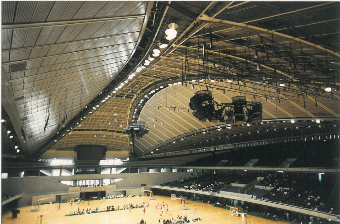
Abb. 4: Innenraum der Sporthalle
