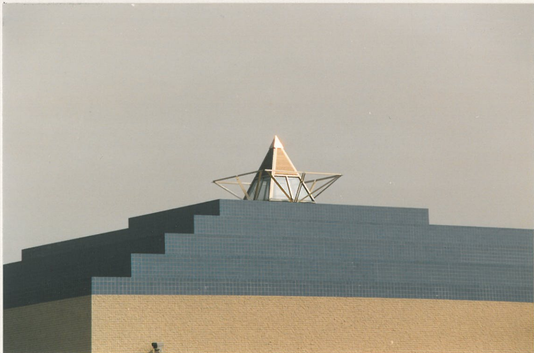
Abb. 7: Dach der Kleinarena
