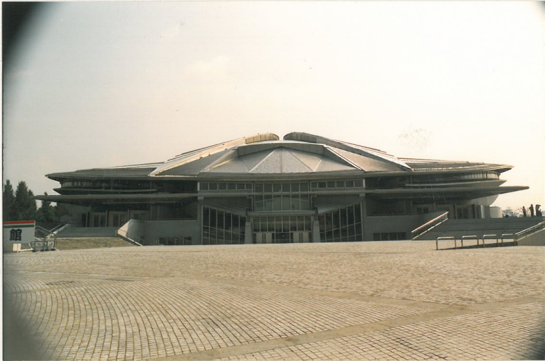
Abb. 2: Zugang zur Sporthalle
