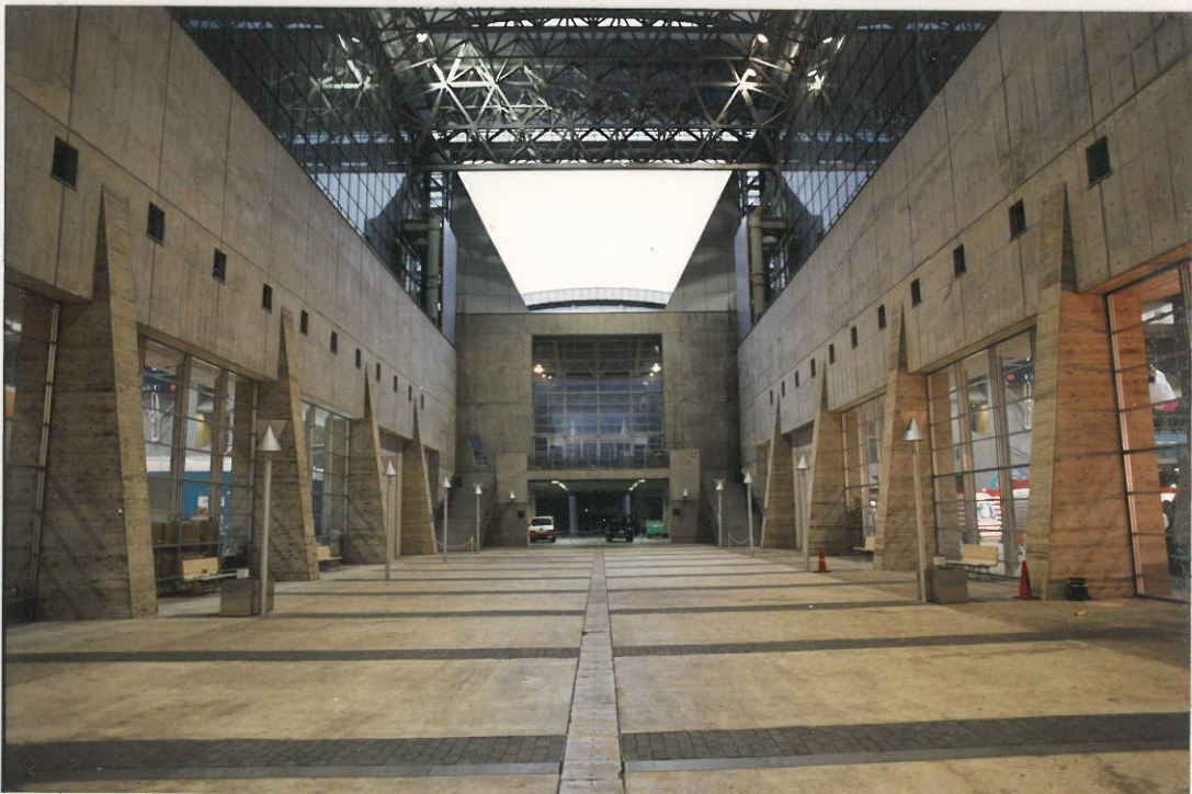
Abb. 15: Zwischen die Hallen geschobene Anlieferung
