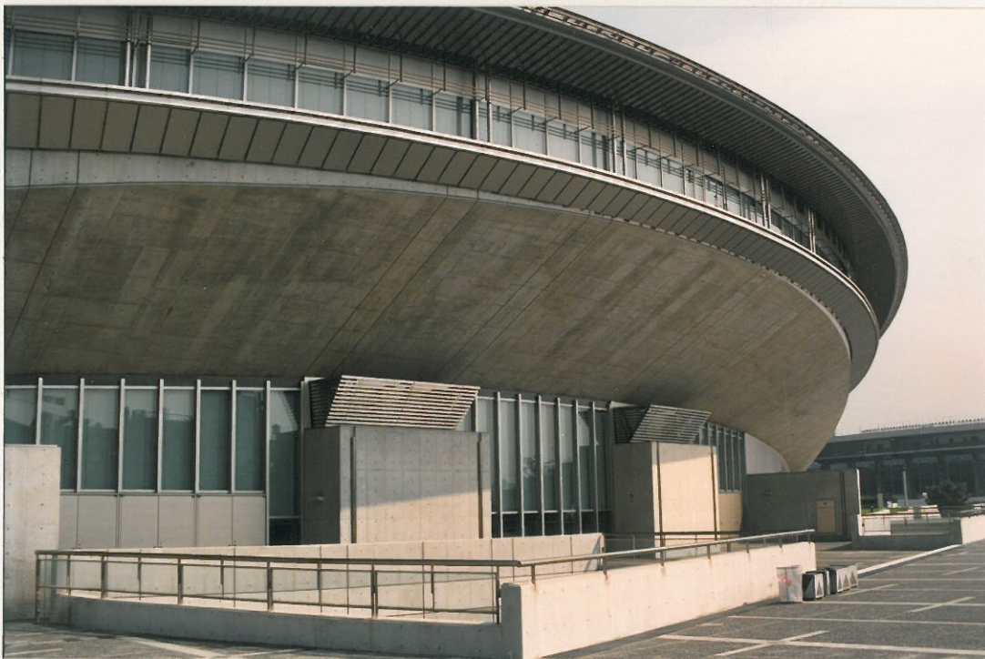
Abb. 5: Aussenwand der Sporthalle
