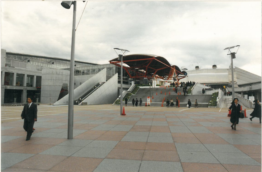
Abb. 12: Das signalrote Eingangsvordach
